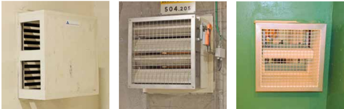
Figure 27 - Clapets de décompression coupe-feu N2
