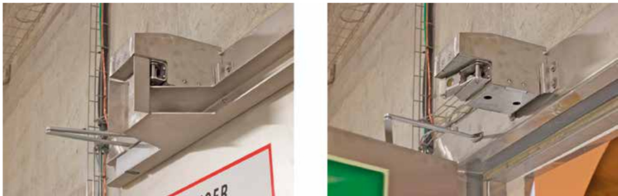
Figure 28 - système d'assistance à l'ouverture des portes par vérin électrique
