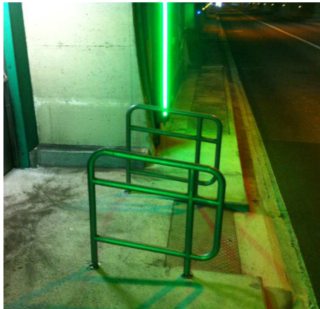
Figure 25 - Mise en place main courante accès PMR
